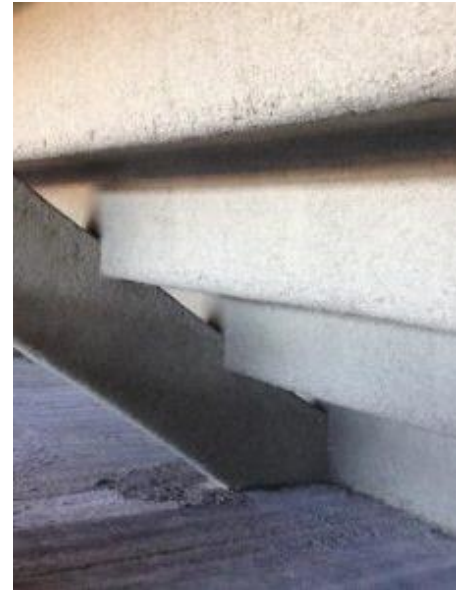
Rosvalla Arena – Läktare
